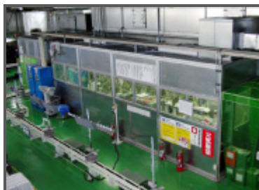
塗装ブース全景
